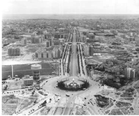
La Castellana en construcción.
